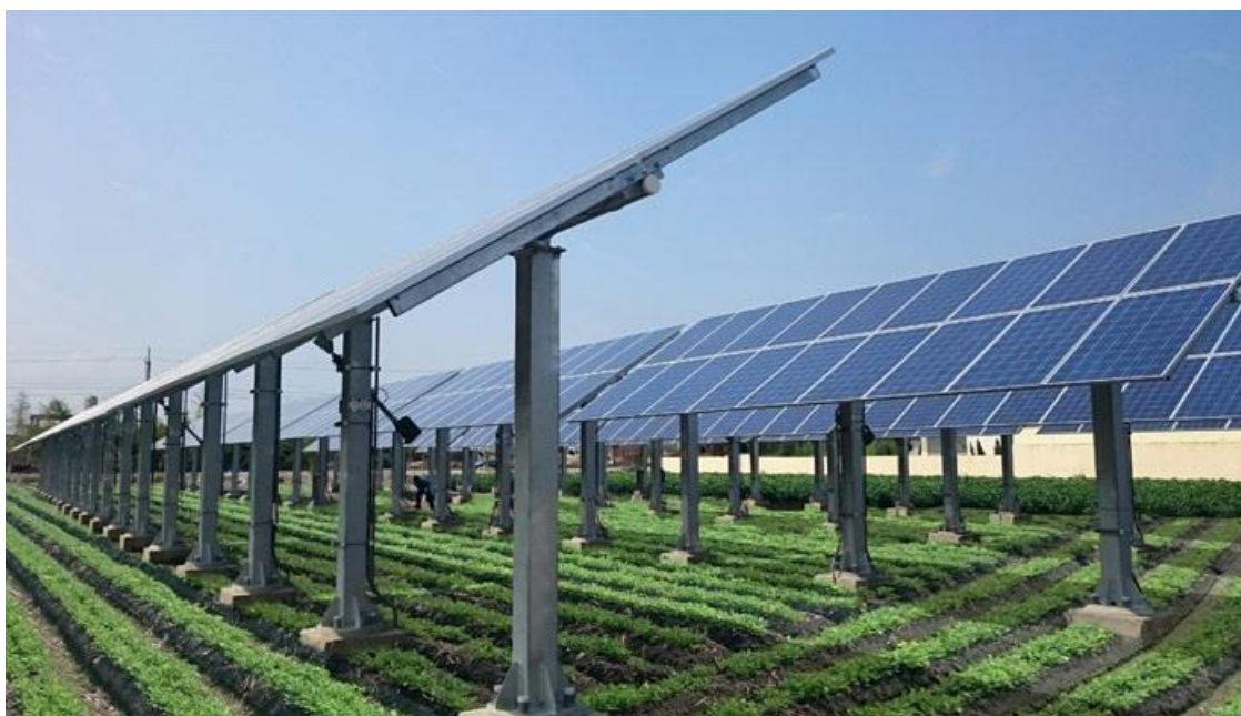
Imaginea 4 – Structura de sustinere panouri fotovoltaice
