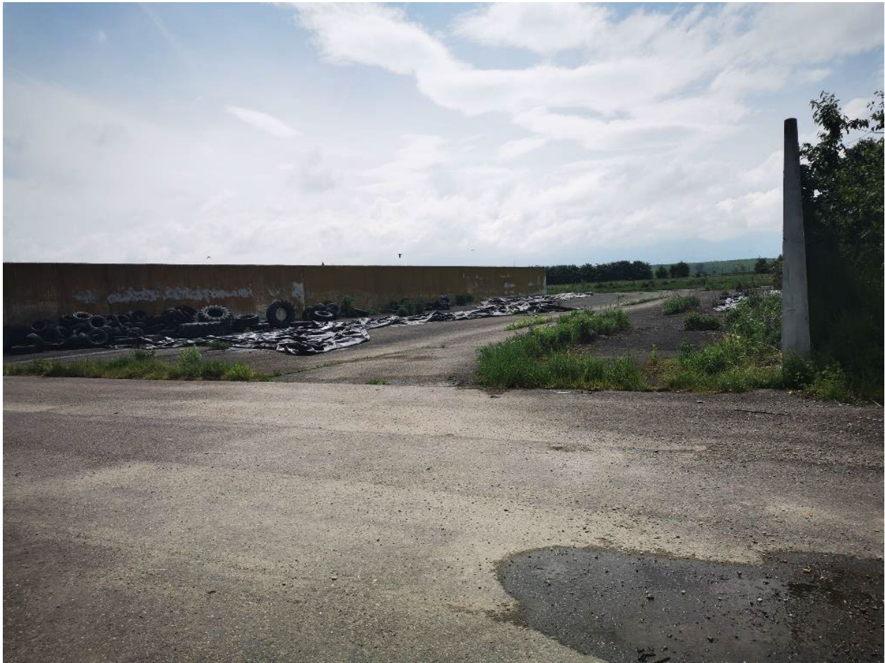
Fig.9 Platforme de insilozare și stație spălare mașini
