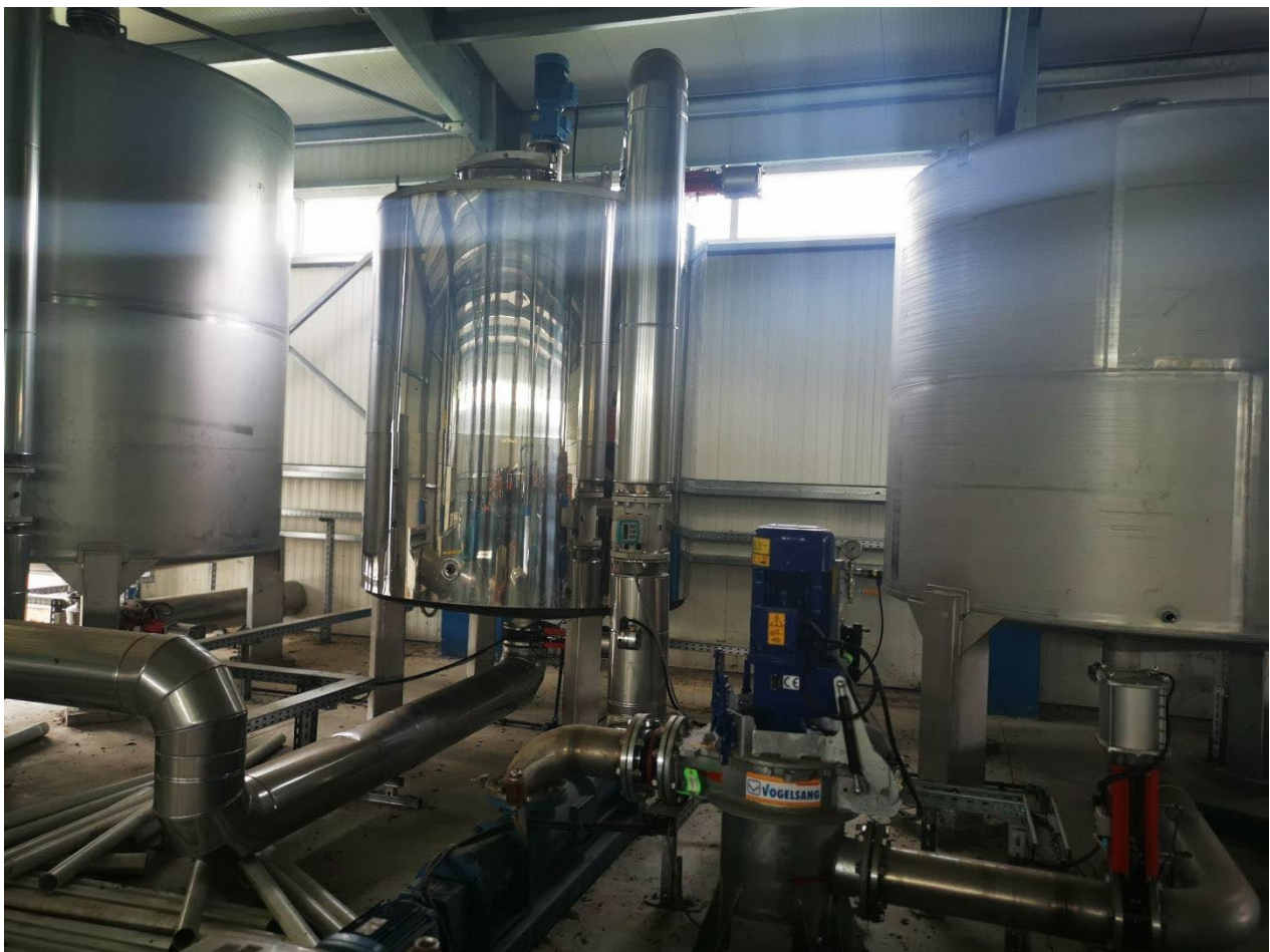
Fig. 12 Imagine din interiorul halei de receptie
