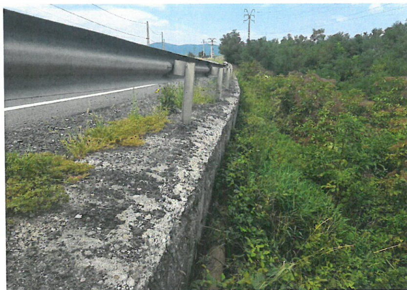
Foto – zidul de sprijin deplasat si rotit
