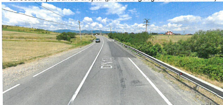
Foto – sectorul afectat km 20+515 – km 20+547 – refacerea zonei afectate (preluare google earth iunie 2022)
