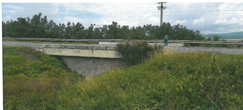
Foto – vedere amonte podet pe DN 13, km 20+547
